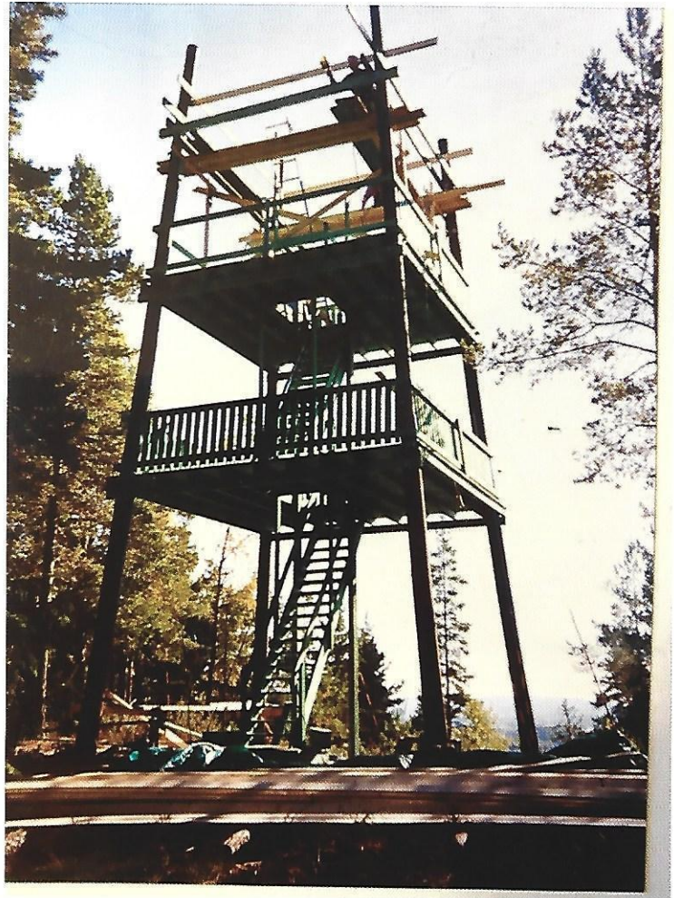
Under byggnation. Foto: Album Gunnar Lidberg
